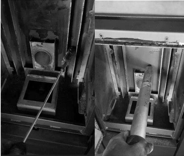
Nettoyage de la chambre de combustion
