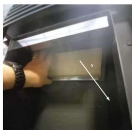
**ATTENTION ! Le nettoyage annuel de la zone située derrière la plaque de la chambre de combustion doit être impeccable**
